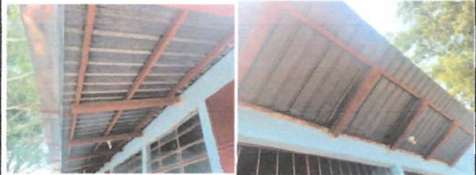
Foto 2: Mantenimiento a estructura metálica existente retiro de óxido, suciedad y pintura deteriorada; incluye cepillado, lijado y aplicación de pintura en el área de aulas y servicios sanitarios.
