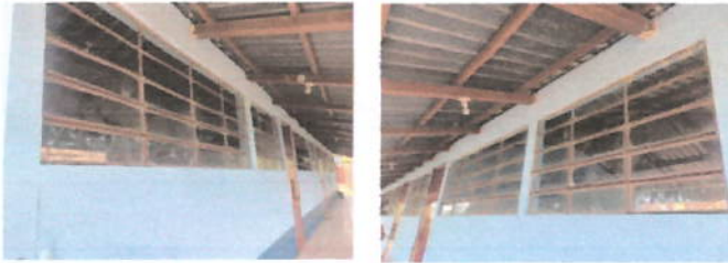
Foto 3: Sustrución de ventanas; sistema de apertura: Corredizas, Perfiles color blanco estandar, Material del marco: PVC Material de la ventana: Vidrio, sellado perimetral.
