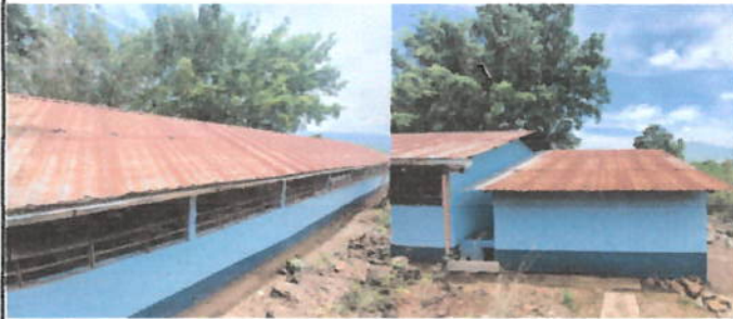
Foto 1: Sustrución de cubierta de techo con lámina galvanizada, Tipo de lámina: troquelada Calibre: 26, incluye: fijaciones y sellado en traslapes, en el área de aulas y servicios sanitarios.
